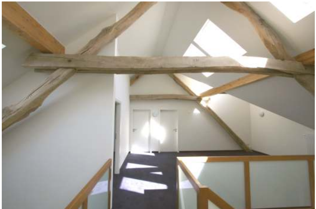
Foto - Obergeschoss mit offenem historischen Dachgebälk
